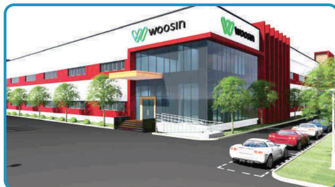
Nhà máy Woosin/ Woosin 공장
